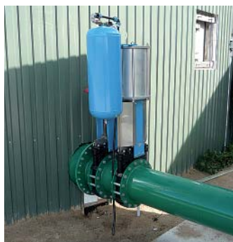
Direkteintrag vom Feststoffdosierer in den Fermenter
