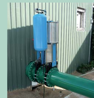
Bezpośrednie wprowadzenie z dozownika materiałów wsadowych do fermentatora
